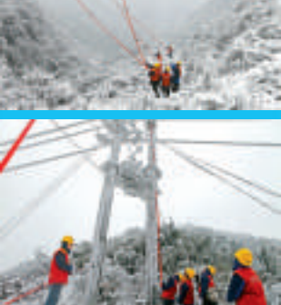
▲電力員工用熱水袋對線路監控攝像頭進行融冰
